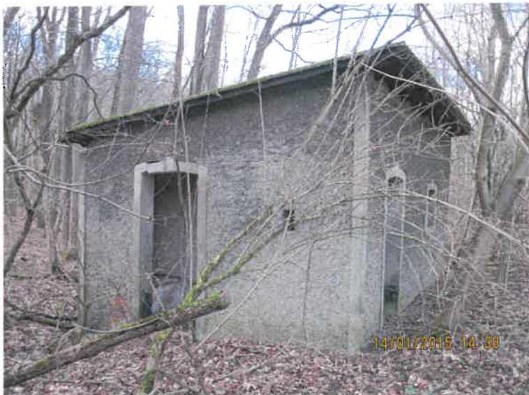
Ansicht des Bahnhofsgebäudes Bischofswald
