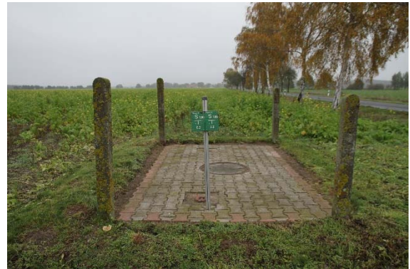
Versiegelte Fläche der Abwasserleitung neben der Kreisstraße K 1141
