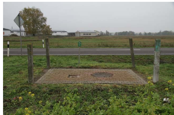
Versiegelte Fläche der Abwasserleitung im Bereich der Landesstraße L 25
